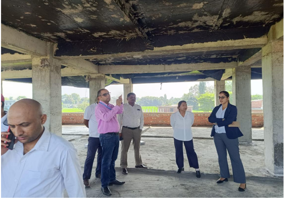
(धनपालथान स्थित निर्माणाधीन प्रशासकीय भवनको अनुगमन)
