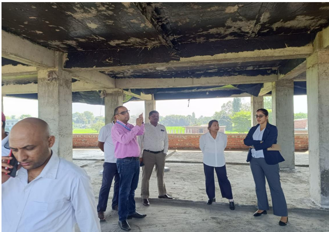
(धनपालथान स्थित निर्माणाधीन प्रशासकीय भवनको अनुगमन)
