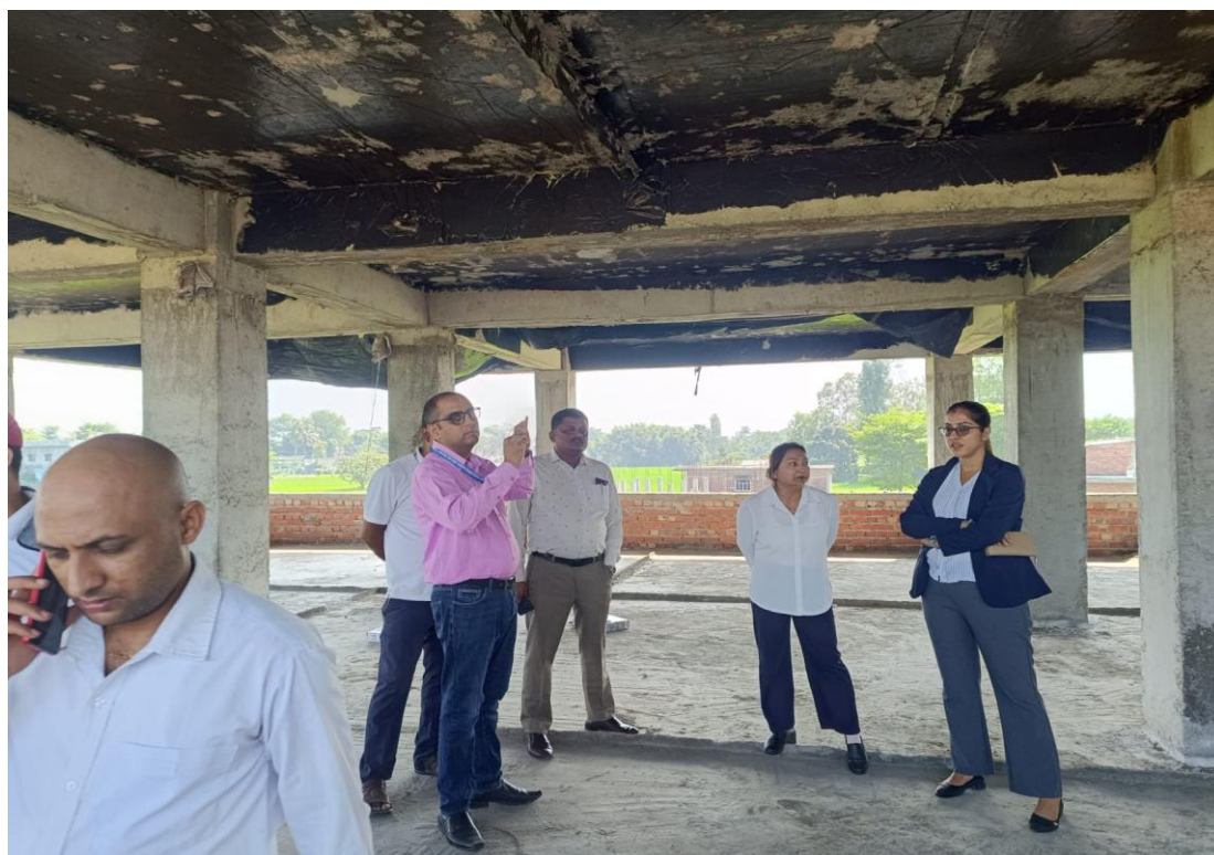
(धनपालथान स्थित निर्माणाधीन प्रशासकीय भवनको अनुगमन)
