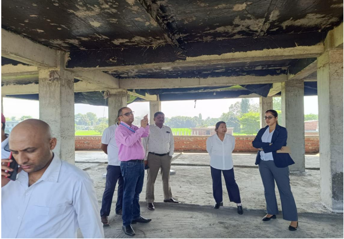
(धनपालथान स्थित निर्माणाधीन प्रशासकीय भवनको अनुगमन)
