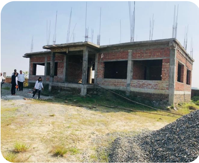
ख. बुढिगंगा गाँउपालिका २ नं वडा कार्यालयको प्रशासनिक भवन
